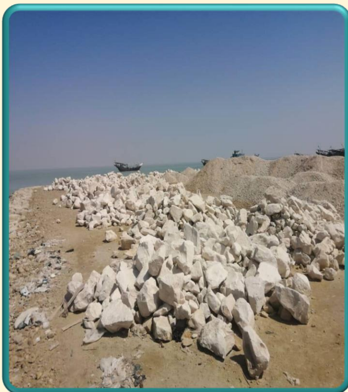
ریختن سنگ آرمور جهت عملیات محوطه سازی در اسکله
