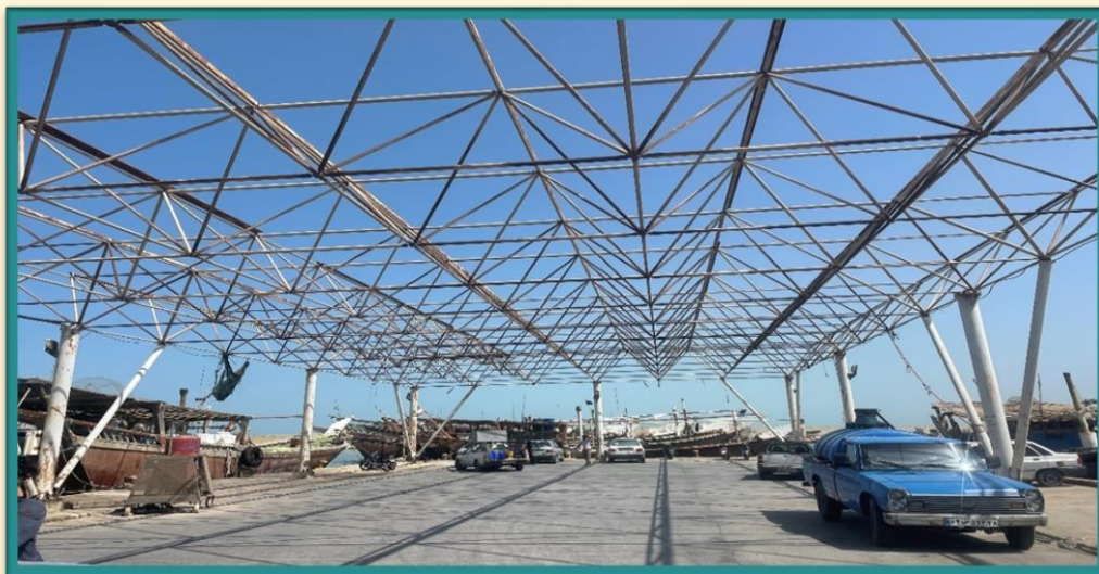
قبل از شروع پروژه
