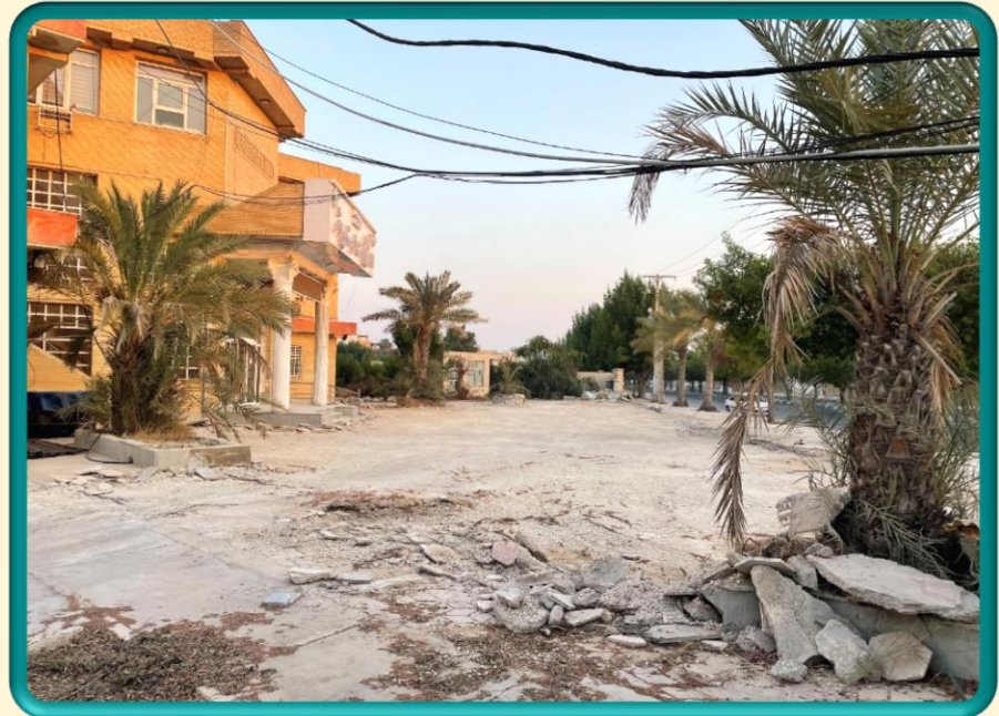
تخریب محوطه اداره کل جهت محوطه سازی و ایجاد فضای سبز
