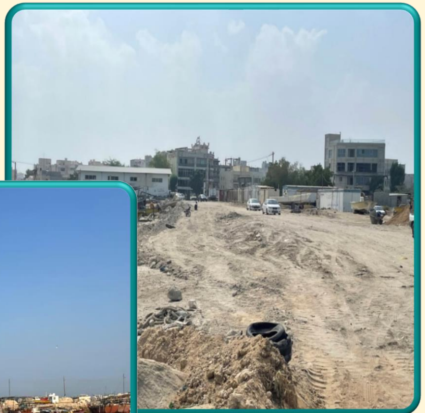
قبل از شروع پروژه
