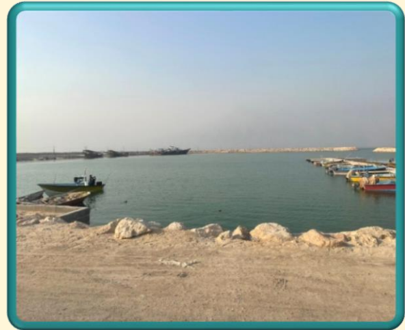
قبل از شروع پروژه
