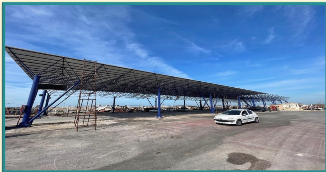
حین اجرای پروژه با پیشرفت فیزیکی ۷۰ درصد
