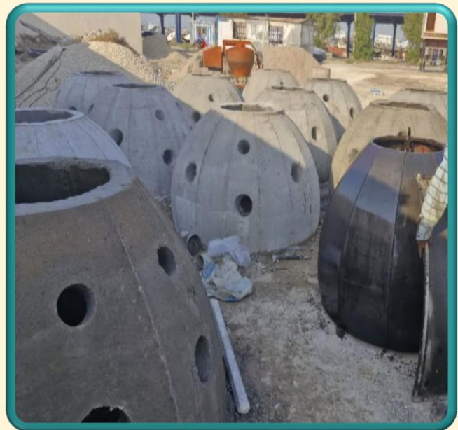
مراحل ساخت زیستگاه مصنوعی در اسکله صیادی دیر
