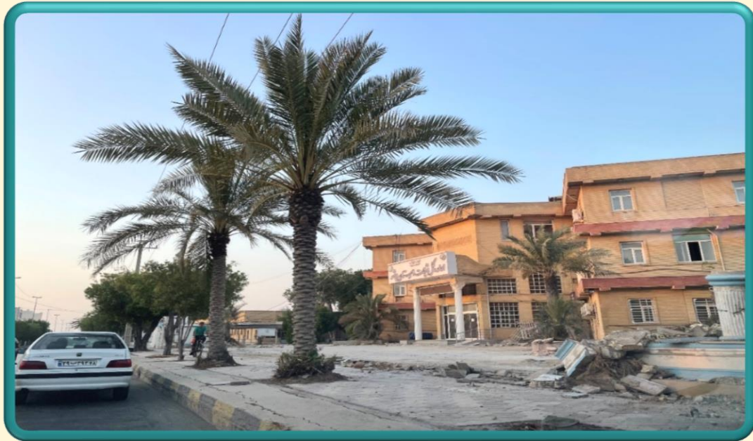
تخریب دیوار اداره کل جهت دیوار کشی
