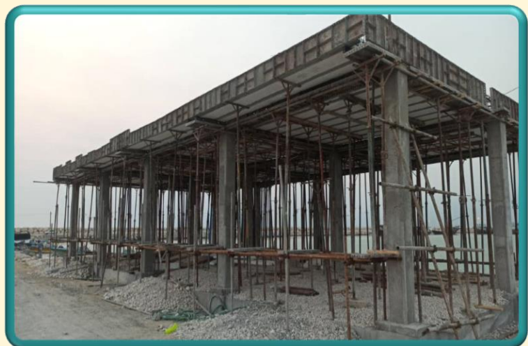
محوطه سازی و ساخت سایبان با پیشرفت فیزیکی ۸۵ درصد
