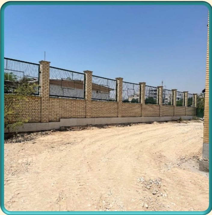
دیوار کشی آجری محوطه یگان حفاظت
